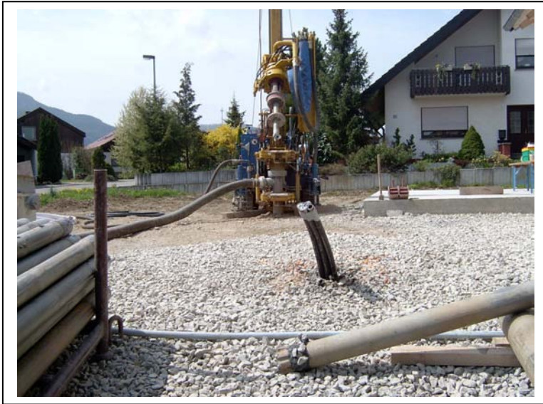
Abb. 3 Sondenbohrungen im Festgestein mit dem Imlochhammer
